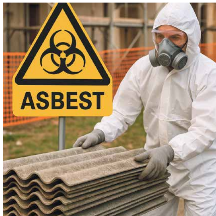
Bei Arbeiten mit Asbest ist Schutz erforderlich. Animation: ChatGPT
