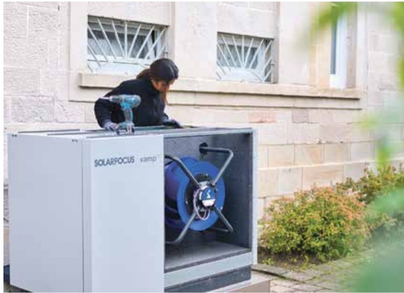
Wartung einer Wärmepumpe.
