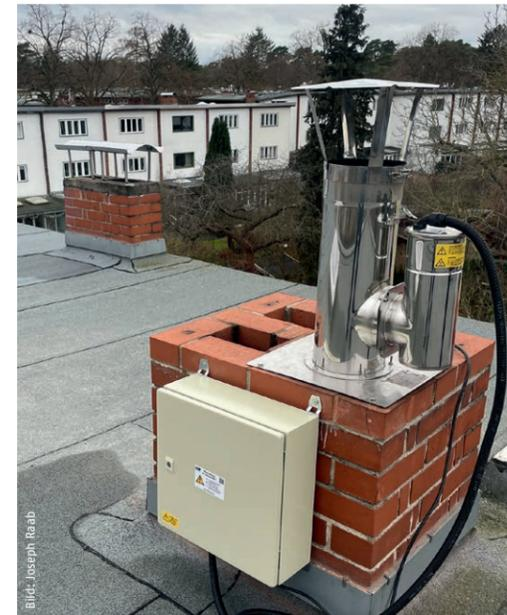
Die erhältlichen Ausführungen des Partikelabscheiders unterscheiden sich nach ihrem Einbauort. Die Basisvariante für Holzessel wird im Abgasrohr eingebaut. Für Öfen bietet Kutzner + Weber die Unter-Dach-Lösung an.
