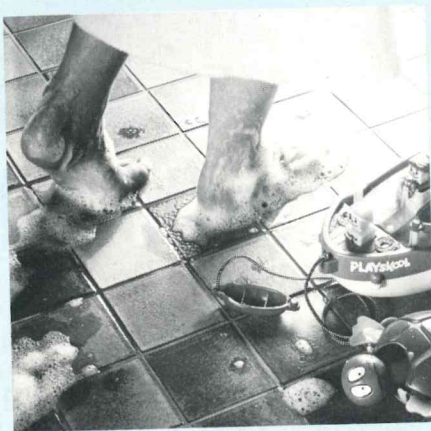
Bild 2: Auf rutschhemmende und pflegeleichte Riff-Fliesen für den Barfußbereich ist zu achten. (Werkbild Laufen Ostara).
