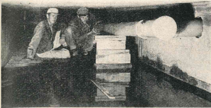
Abb. 3: Montage von Gabodur KA-Abflußrohren an der Autobahnbrücke München-Freimann
