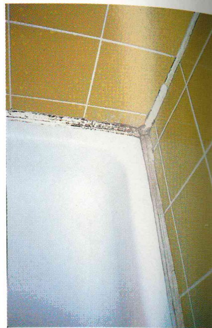
Vom Dauerangriff durch Mikroorganismen eindrucksvoll gekennzeichnete Silikonfuge an einer Duschwanne.
