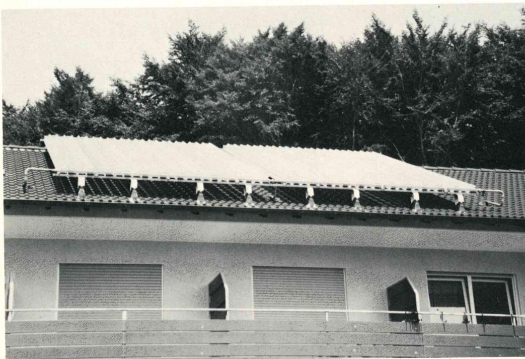
Bild 6: Eine weitere Energiesammler-Variante: das Energiedach
