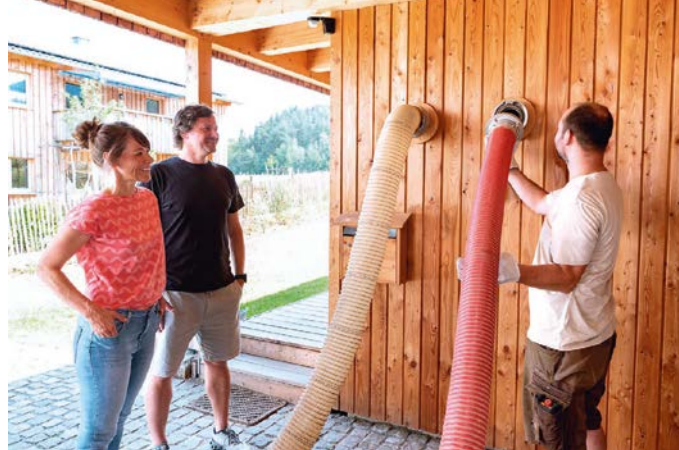
Sauber und schnell: Die Pelletlieferung inkl. Einblasen in das Lager dauert in etwa eine halbe Stunde.
