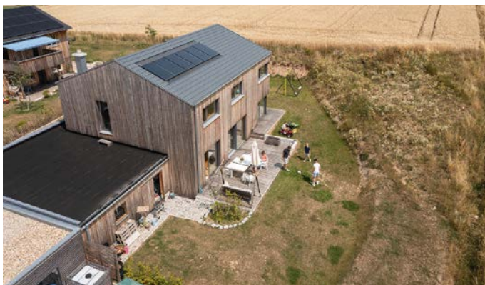
Das Holzhaus in der Oberpfalz wird mit Pellets beheizt – alles heimisch und klimafreundlich. Die Solaranlage auf dem Dach sorgt für Warmwasser im Sommer und unterstützt mit Heizwärme in den Übergangsmonaten.
