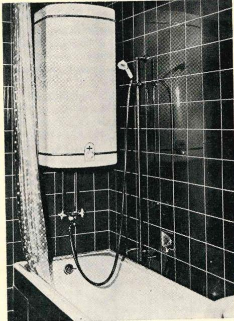
Abb. 3: Niederdruckspeicher in gefälliger Flachbauweise mit 80 Liter Nutzinhalt
