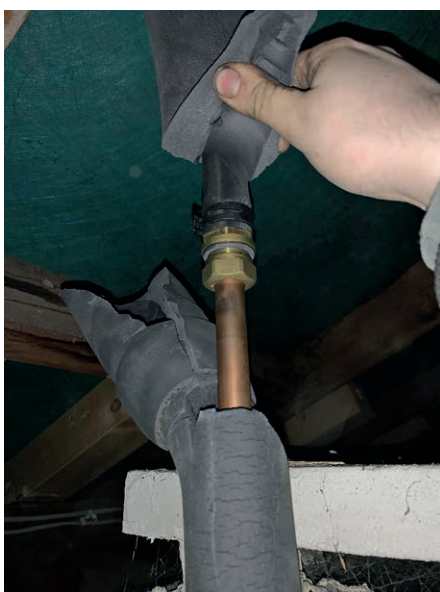
Beispielhafte Schnellverschraubung als zugelassene Verbindung zwischen Kupfer- und Edelstahlwellenrohr als Übergangverschraubung.
