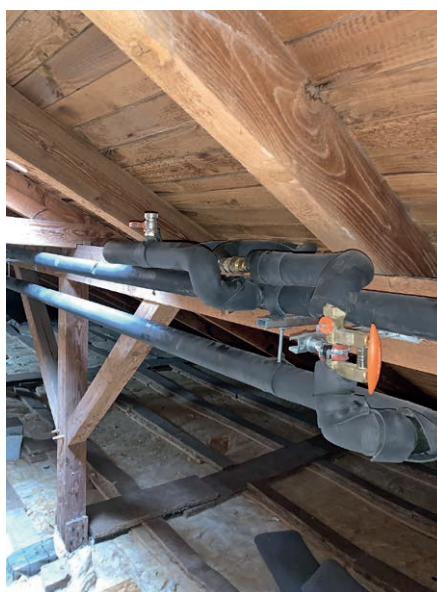
Installation eines zugelassenen Entleerungs- sowie eines Abgleichventils.
