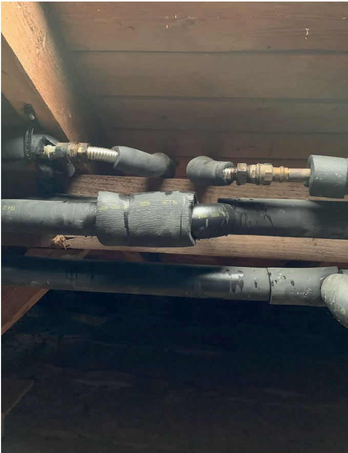
Undichtigkeiten wg. Pappdichtungen, Teflondichtfaden und nicht flachdichtenden Doppelnippeln.
