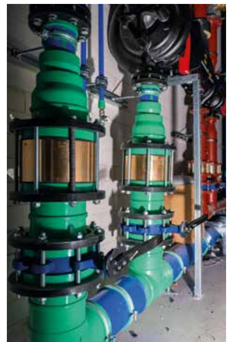
Abbildung 5: Im Gegensatz zu Stahl punktet Polypropylen durch deutlich geringere CO 2 -Emissionen.
