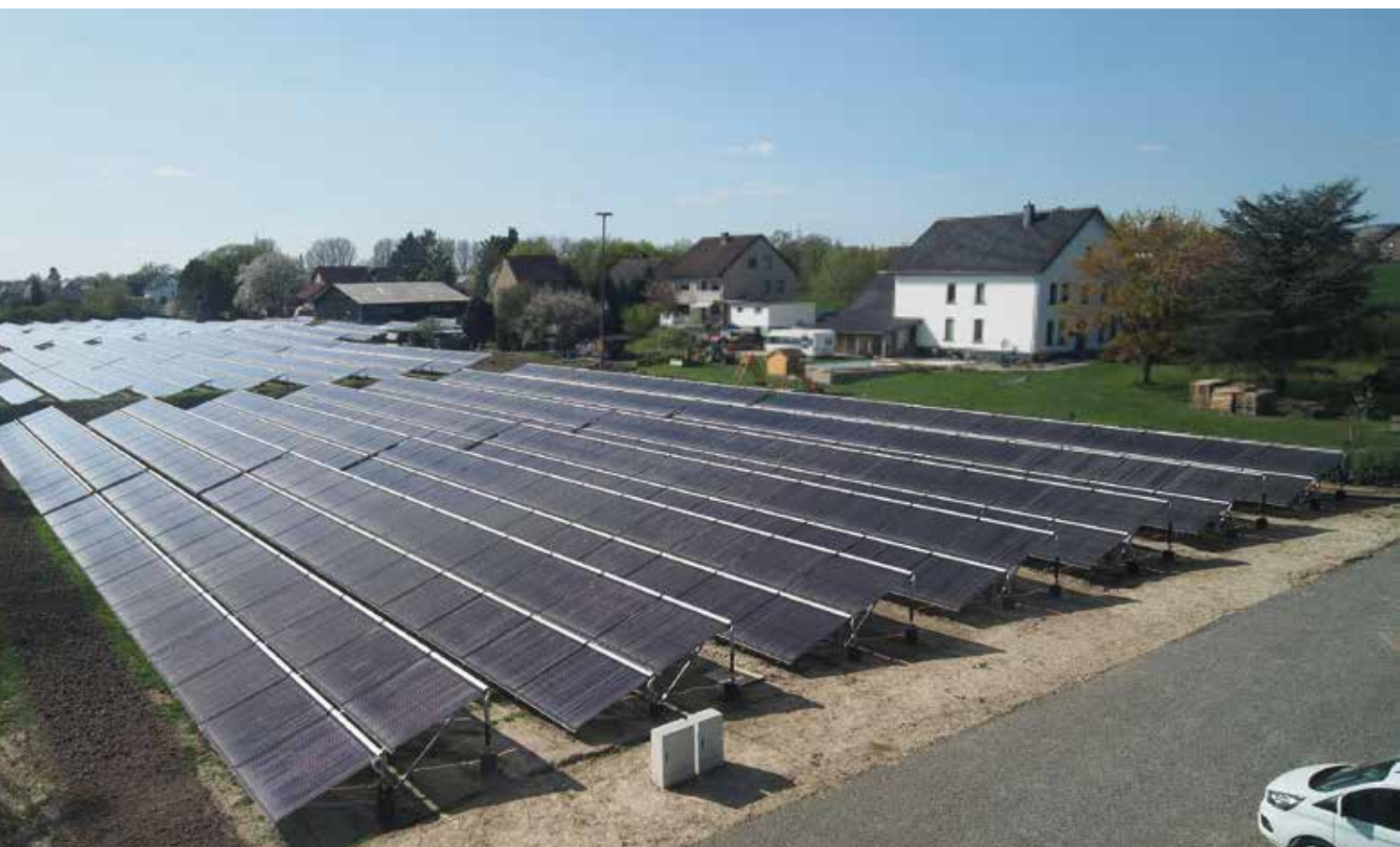
Abbildung 1: Eine Solarthermieanlage mit einer Kollektorfläche von rund 9.000 Quadratmeter unterstützt die Fernwärmeversorgung der Stadtwerke Lemgo.
