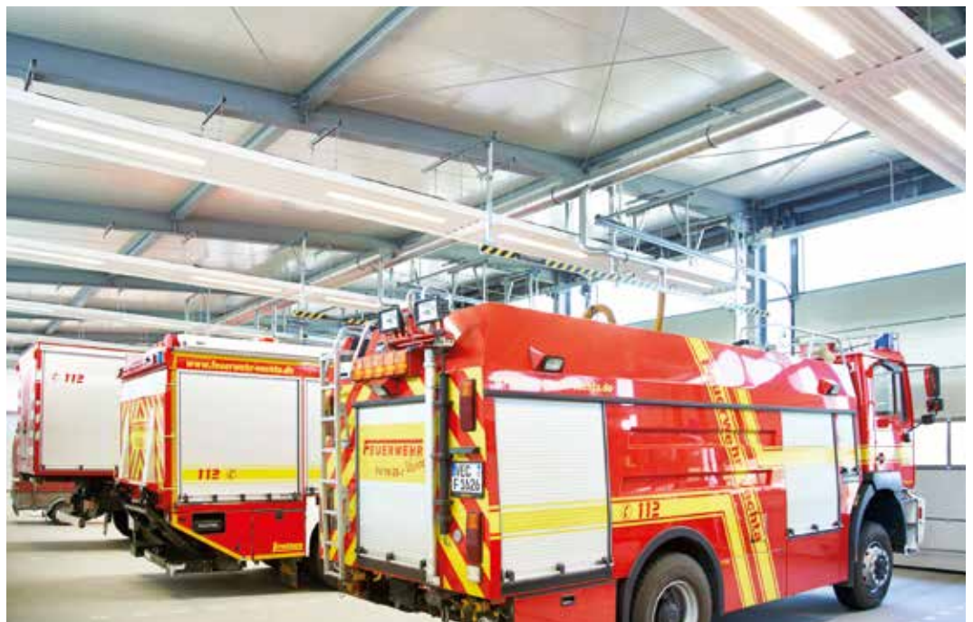
Abbildung 3: Ein Vorteil der Deckenstrahlplatten ist das schnelle Erwärmen der Räume. Feuerwehrleute wissen das nach schweißtreibenden Einsätzen besonders zu schätzen.
