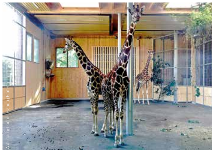
Abbildung 3: Im Giraffenhaus sind die gelben Heizbänder in acht Meter Höhe montiert.
