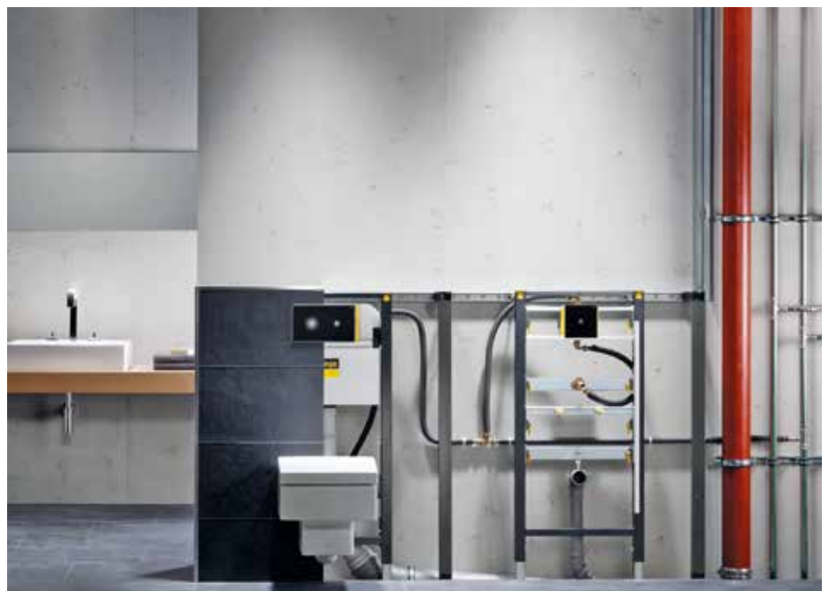
Abbildung 5: Die durchgeschliffenen Reihenleitungen mit einem Hauptverbraucher am Ende schützen nicht nur vor Stagnation, sie geben zugleich deutlich weniger Wärme als bei einer Zirkulation in die Vorwand ab.
