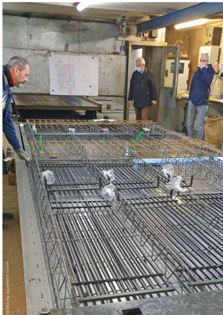
Abbildung 3: Das Flächenheiz- und Kühlsystem wurde direkt in die Betonfertigdecke eingebracht.
