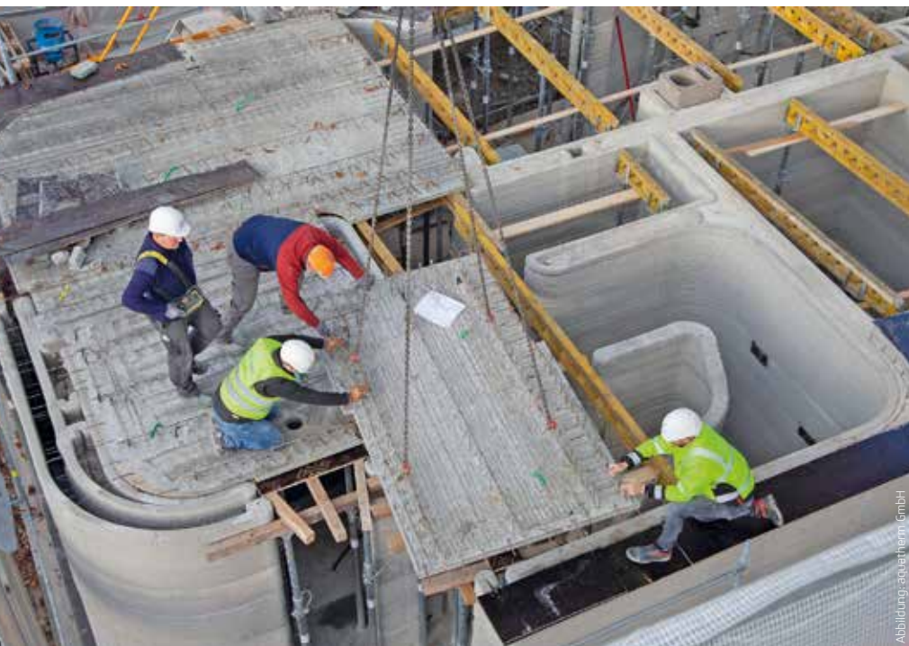
Abbildung 5: Auf der Baustelle mussten die einzelnen Fertigteildeckenelemente nur noch miteinander verbunden werden.
