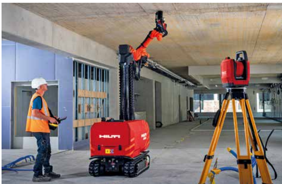
Abbildung 5: Einsatz des computergesteuerten Bohrroboters Hilti Jaibot für Überkopf-Bohrungen
