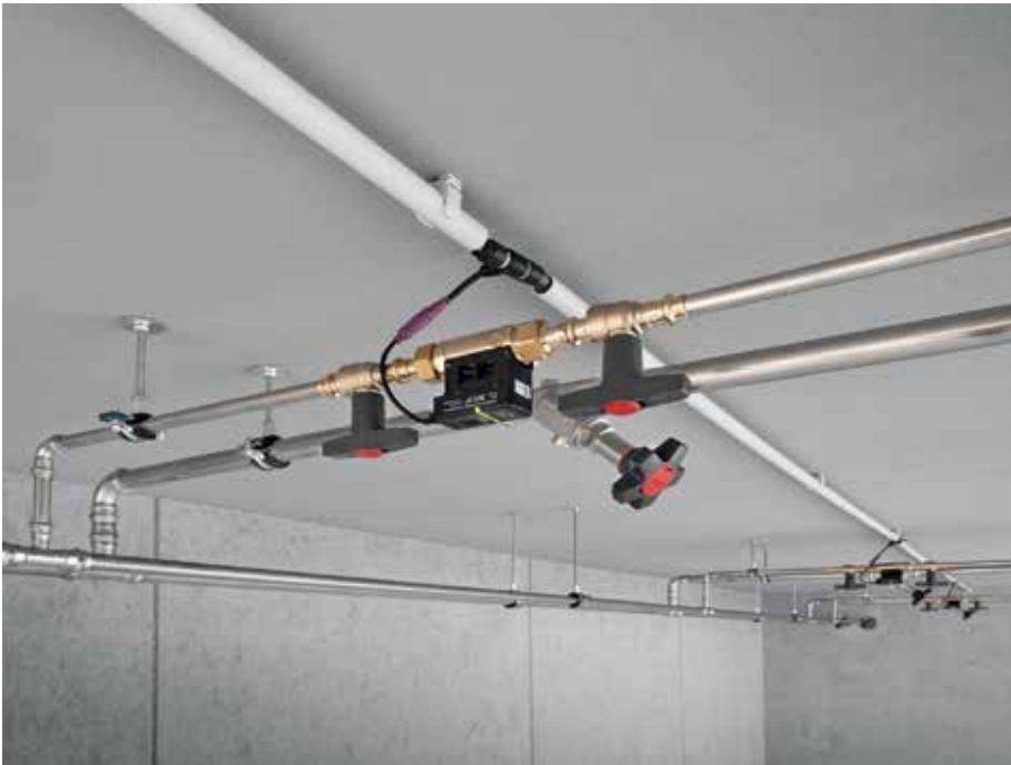
Abbildung 4: Der präzise thermische Abgleich von Trinkwasser-Installationen, beispielsweise über elektronische Zirkulationsregulierventile, unterstützt nicht nur den Erhalt der Trinkwasserhygiene, sondern verhindert gleichzeitig die Verschwendung von Energie.
