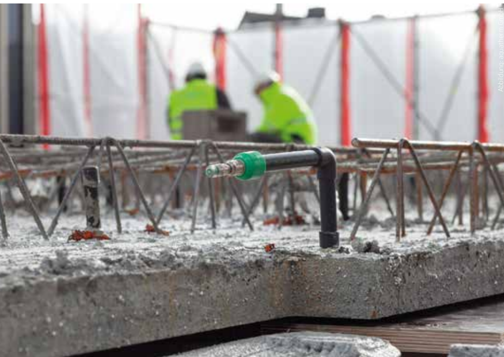
Abbildung 4: Nach dem Eingießen des Betons ist nur noch der Anschluss des Systems zu sehen.
