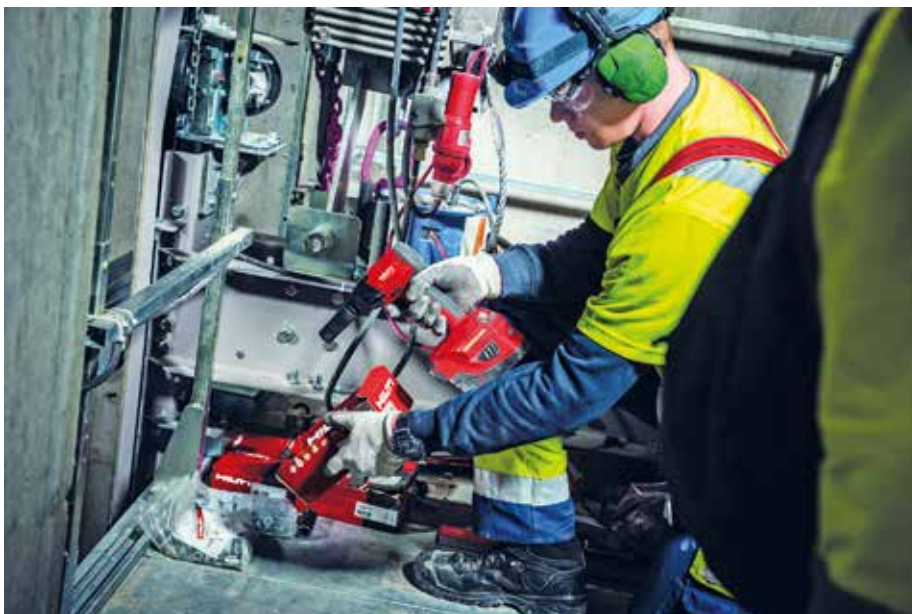
Abbildung 4: Gerätegestützte Kontrolle des Drehmoments
