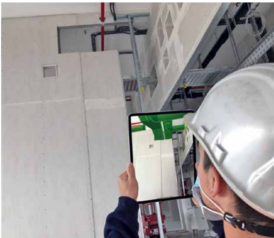
Abbildung 4: Visueller Abgleich von Planung und Ausführung mit AR
