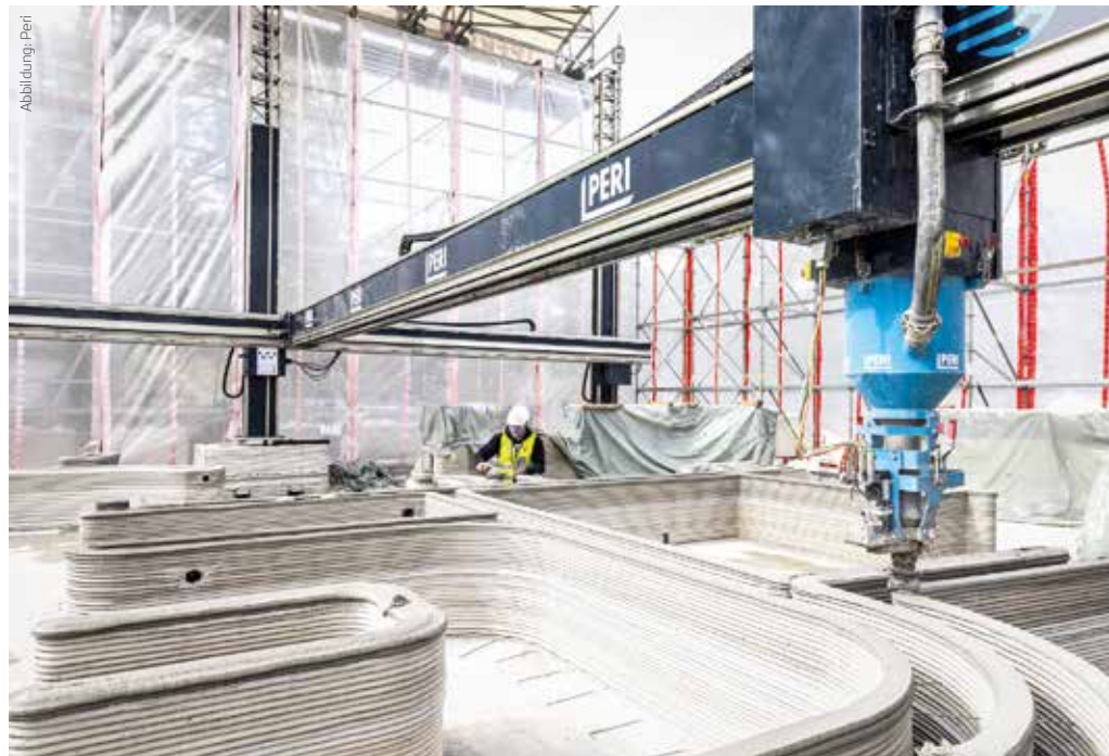
Abbildung 2: Der Druckkopf des 3D-Druckers bewegt sich über drei Achsen auf einem fest installierten Metallrahmen.
