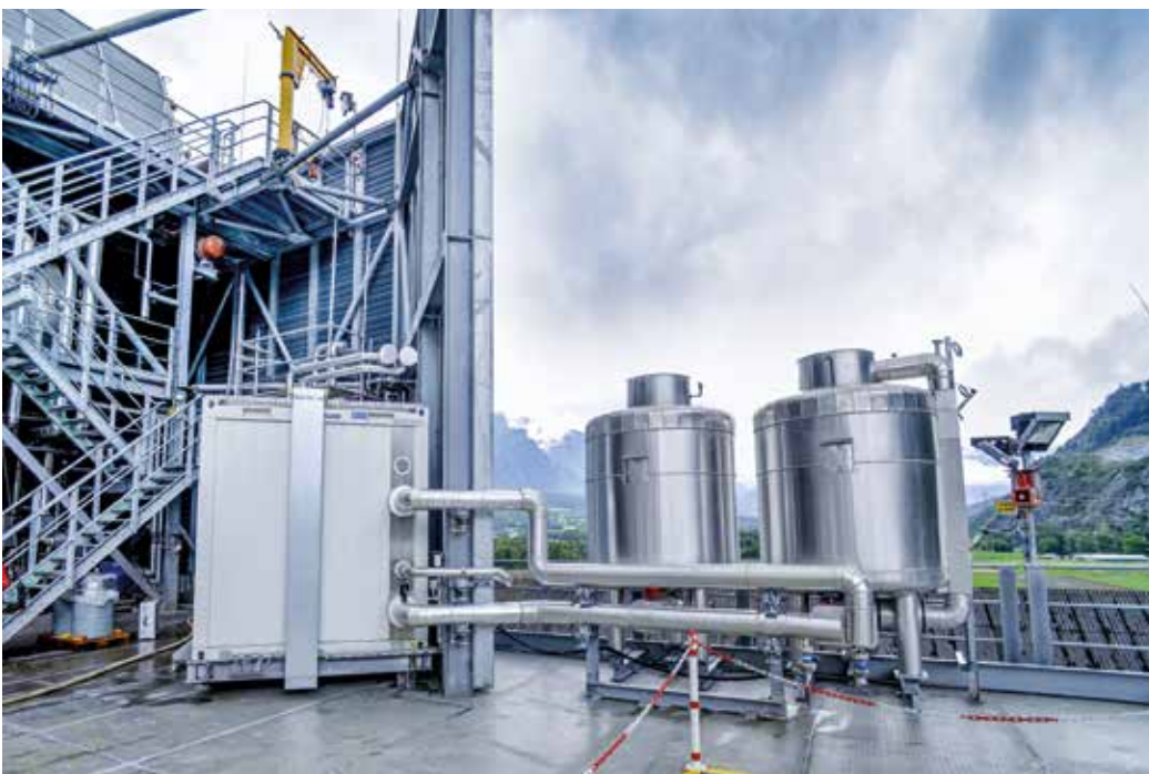
Abbildung 3: Untervaz (CH): Vorfertigung einer Druckhaltestation – im Freien installiert
