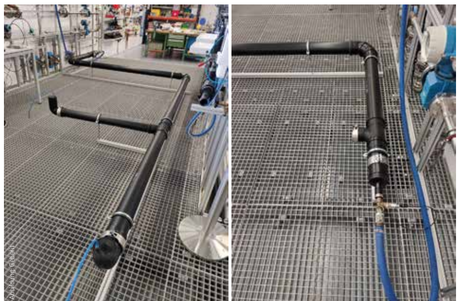
Abbildung 2: Prüfstand bei Geberit
