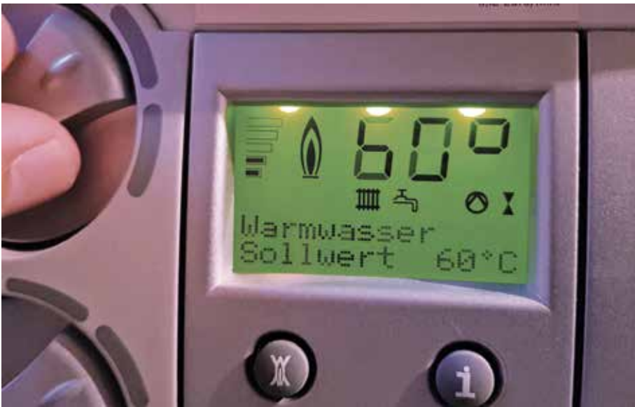
Abbildung 7: Um zu einer signifikanten Verringerung des Energiebedarfs für Trinkwasser warm zu kommen, muss perspektivisch eine Absenkung der geforderten Systemtemperaturen von derzeit noch 60/55 °C auf weniger als 50 °C erfolgen.
