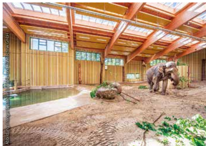
Abbildung 2: Aufgrund der hohen Luftfeuchtigkeit im Elefantenhaus müssen die Deckenstrahlplatten besonders korrosionsbeständig sein. Die LED-Beleuchtung mit vorgesetzter Schutzscheibe ist in die gelben Deckenstrahlplatten integriert.
