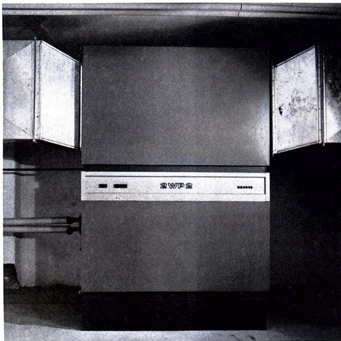
Bild 1: Luft/Wasser-Wärmepumpe für die Innenaufstellung
